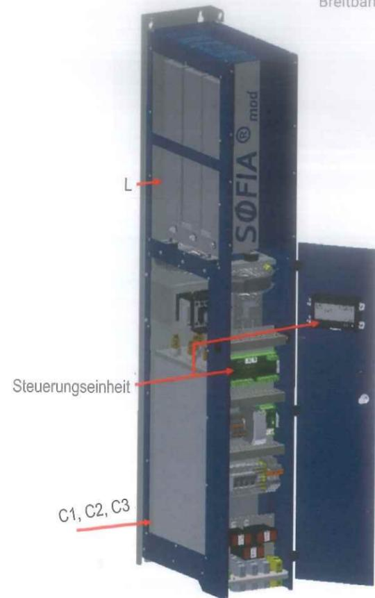
Bild 1 | Aufbau eines Sofia-Mod-Filtermoduls (100A). Wichtigster Bestandteil und Gehirn des Filters ist die intelligente Steuerungseinheit.
